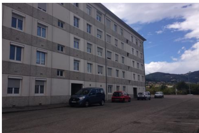
■ Les pompiers sont intervenus pour une fumée importante dans la cage d'escalier de cet immeuble. Photo DR
